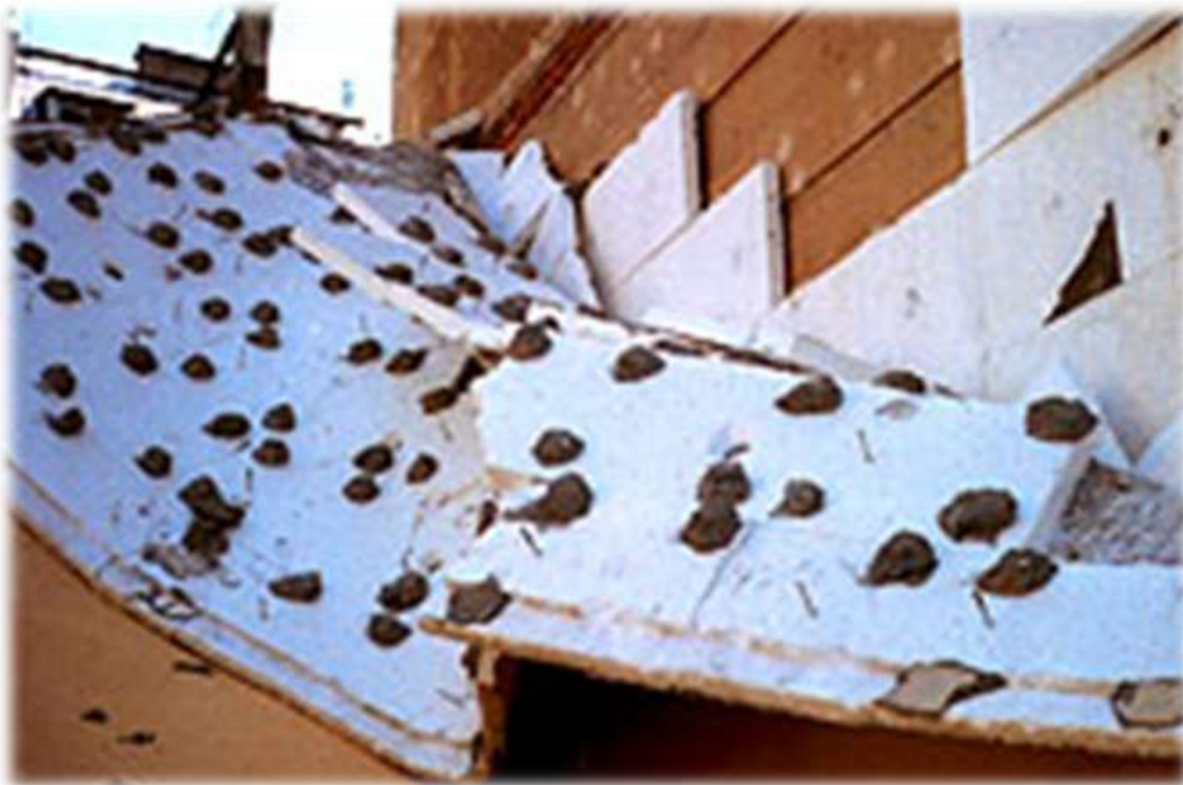
Errato incollaggio pannelli EPS
