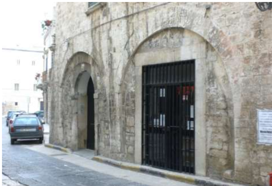
Tracce di fornicì, in seguito tamponati, che testimoniano l'esistenza di logge mercantili
