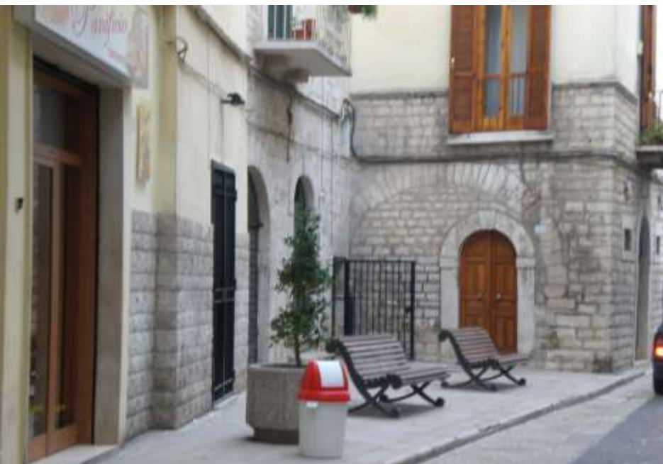
Tracce di fornicì, in seguito tamponati, che testimoniano l'esistenza di logge mercantili
