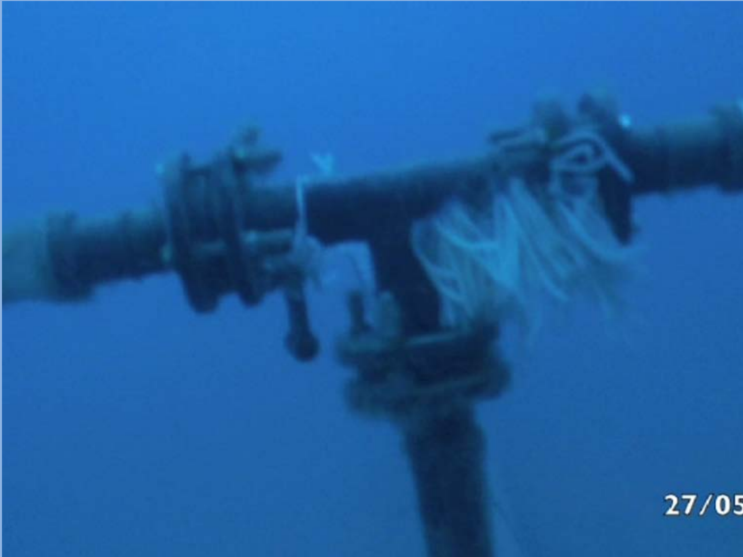
CONDOTTA SOTTOMARINA Tratta Terminale con Diffusore
