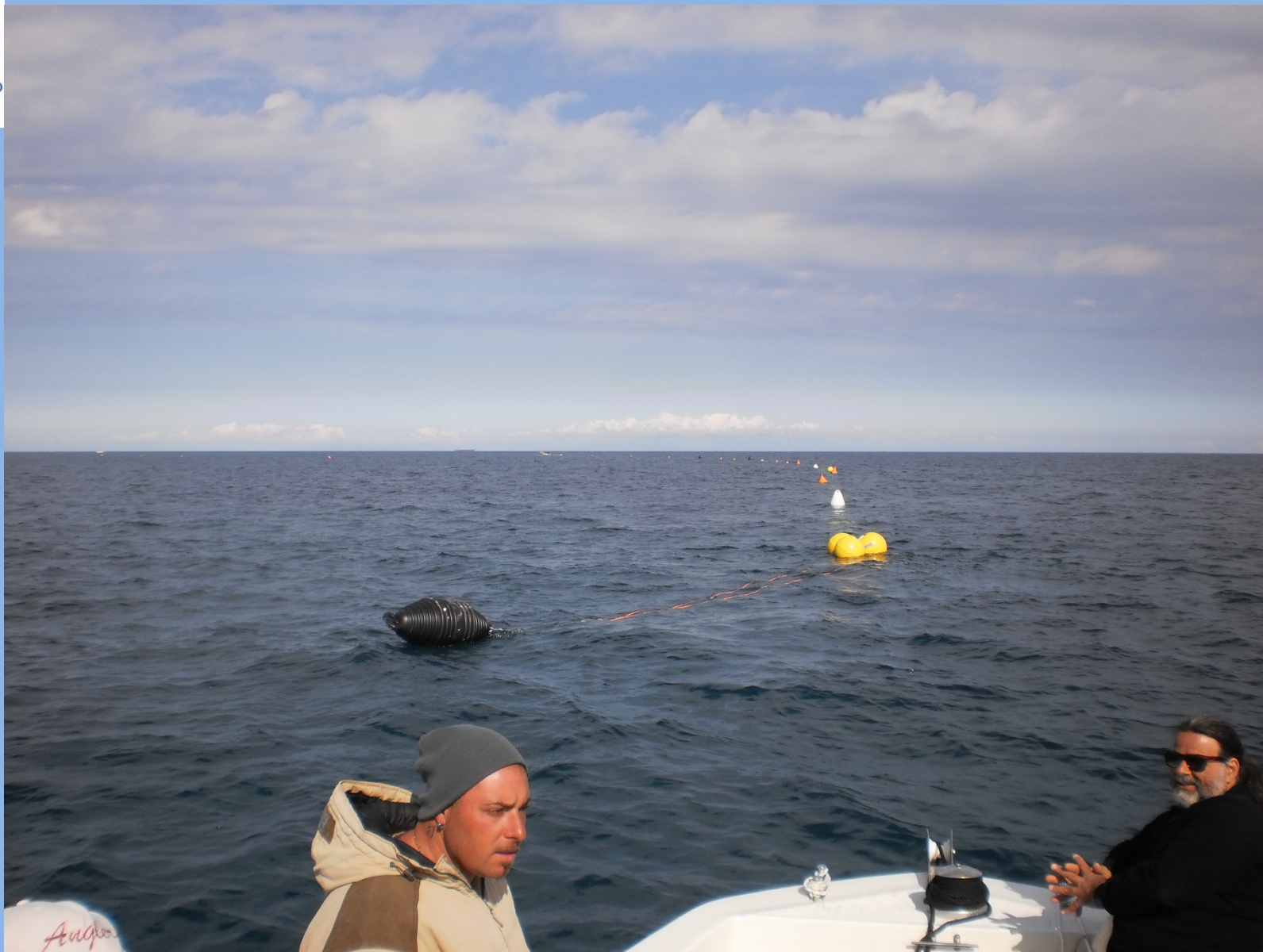
VARO CONDOTTA SOTTOMARINA ALTO FONDALE recupero boe galleggianti
