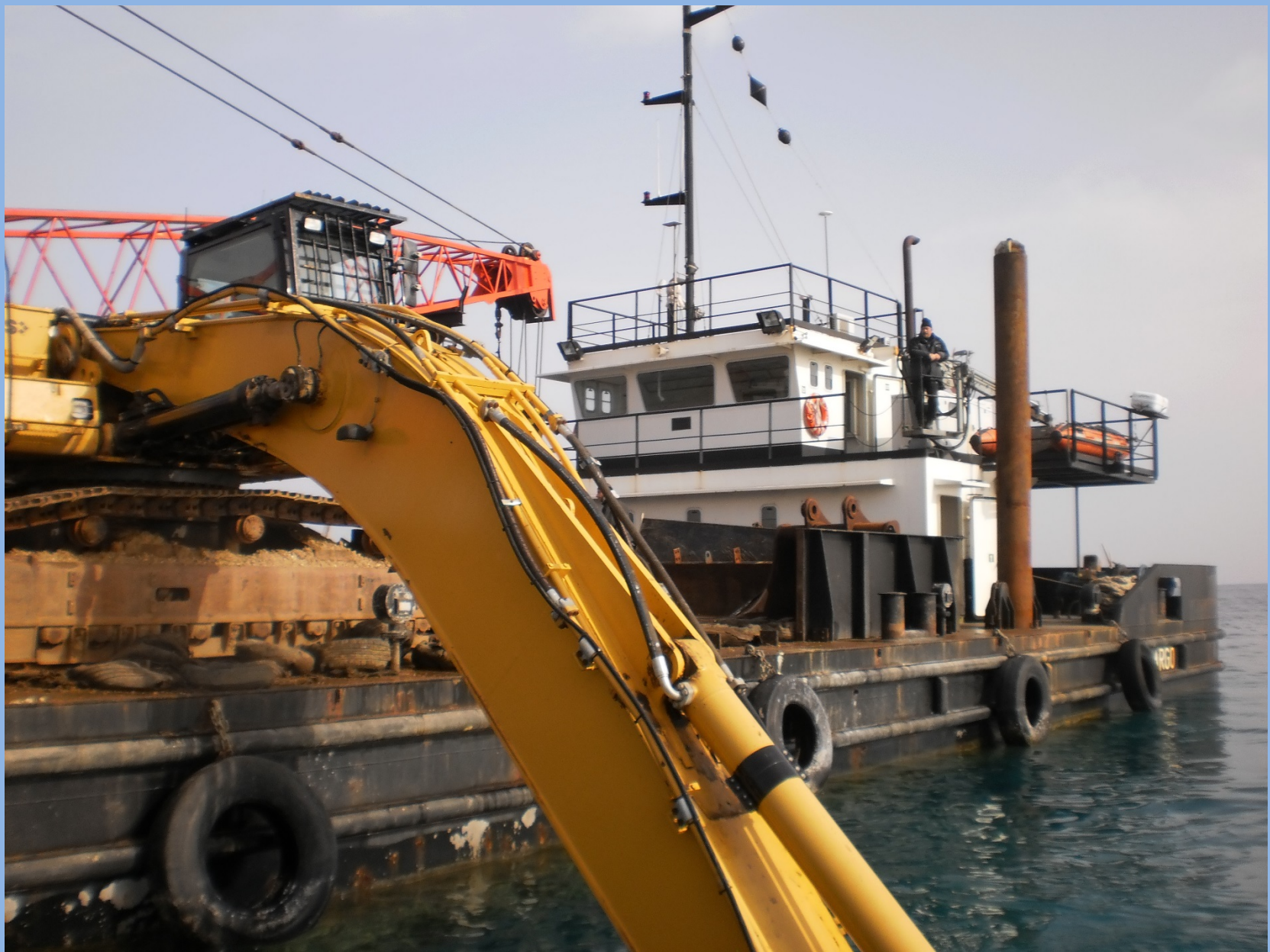
SCAVO DA PONTONE CON BRACCIO MECCANICO
