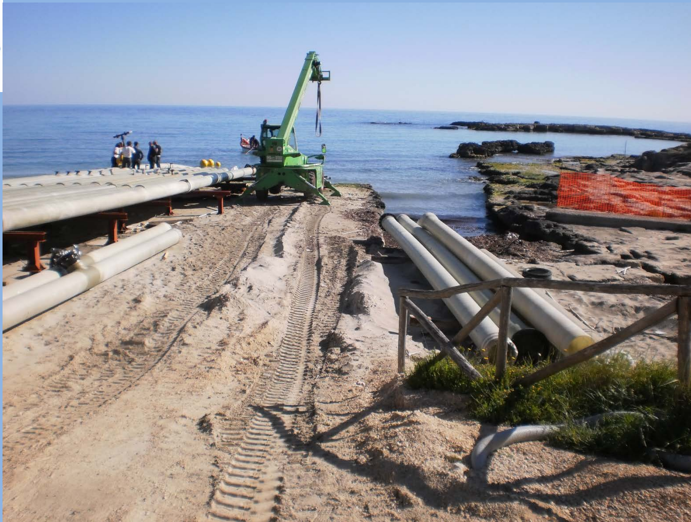
VARO CONDOTTA SOTTOMARINA ALTO FONDALE parte terminale della sottomarina Montaggio Diffusori / Tratta da 2000 mt a 2500 mt
