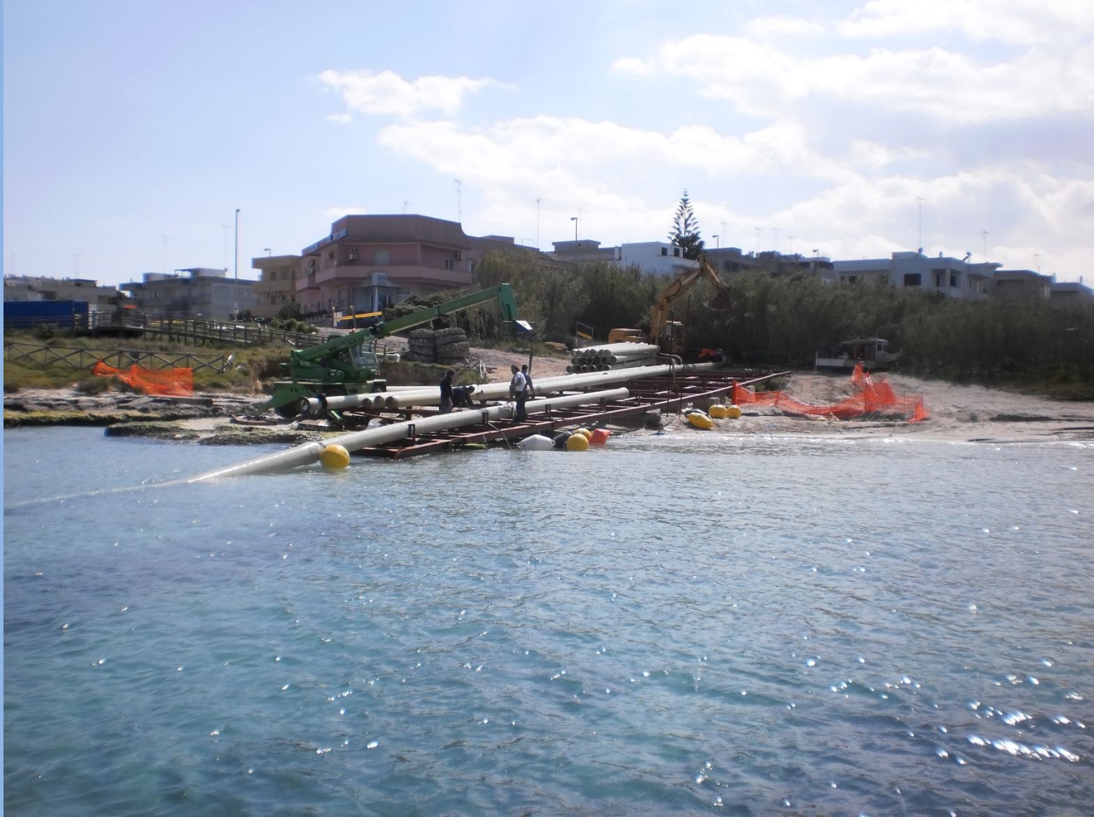
VARO CONDOTTA SOTTOMARINA ALTO FONDALE varo stringa ed affondamento di tipo semisommersa
