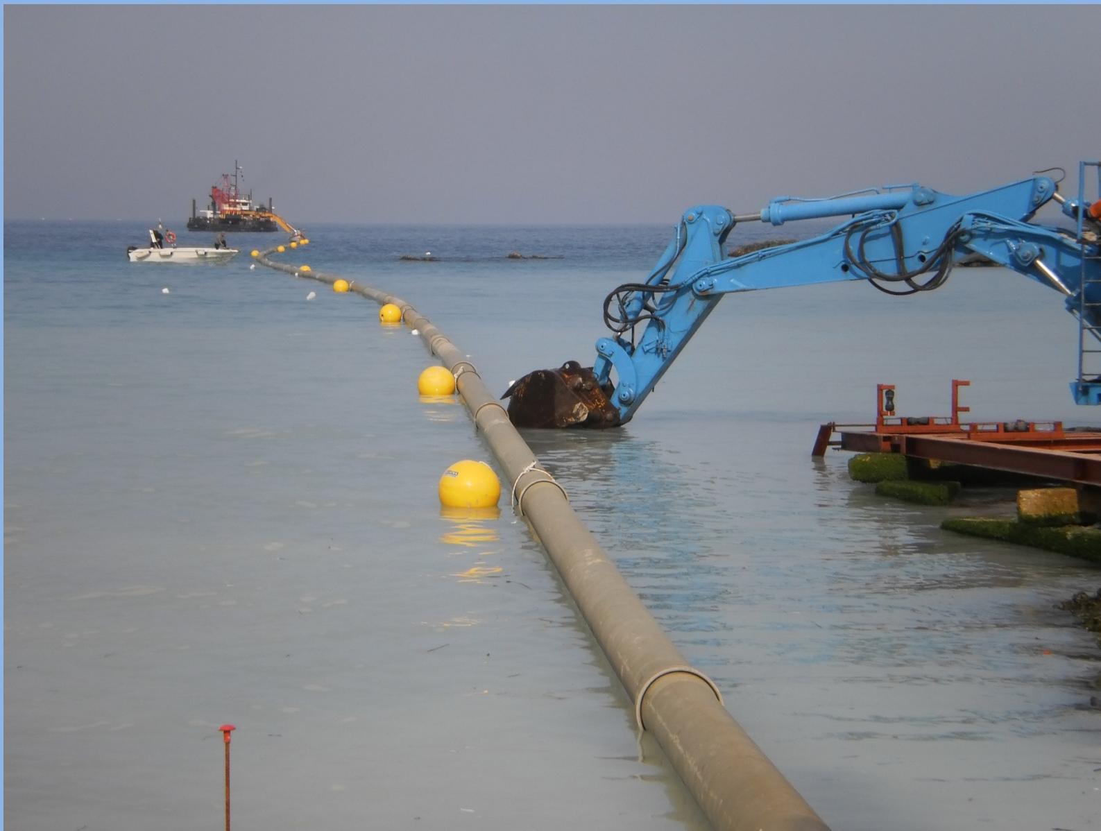
VARO CONDOTTA SOTTOMARINA ALTA ADATTABILITA' DELLA TUBAZIONE FLESSIBILE ALLE CONDIZIONI METEOMARINE
