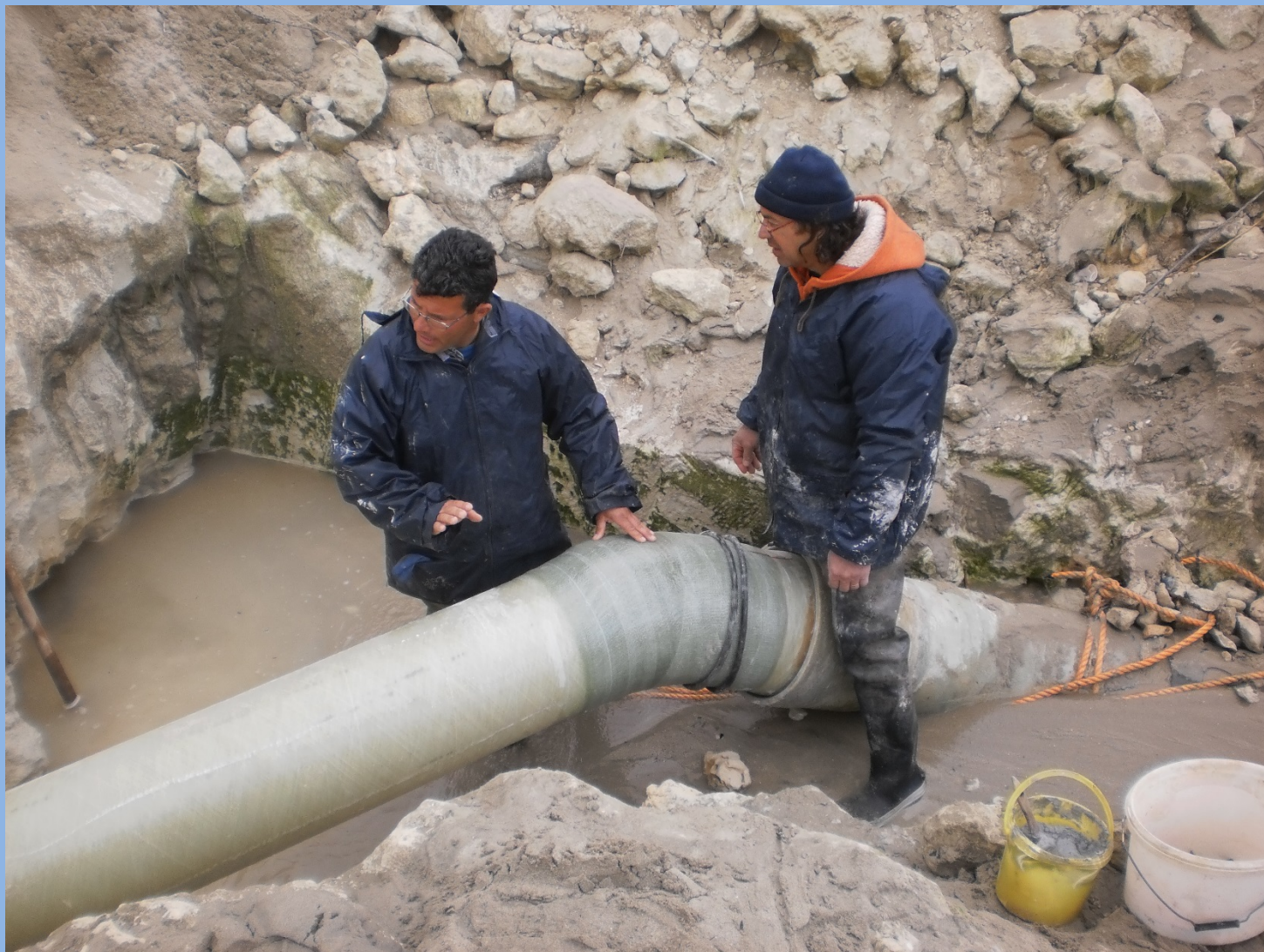
VARO CONDOTTA SOTTOMARINA ALTO FONDALE pezzo speciale curva predisposta in stabilimento
