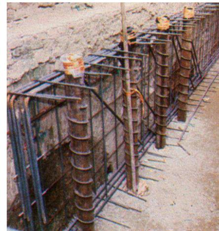
SOTTOFONDAZIONE CON MICROPALI PRECOMPRESSI
