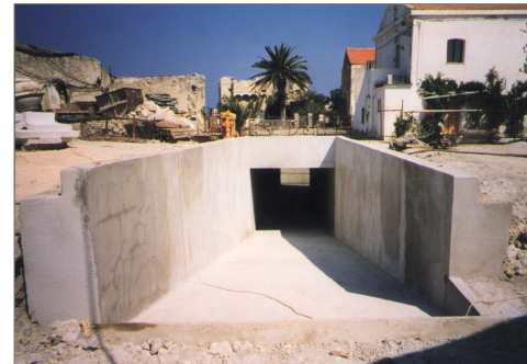
La rampe di uscita dei trattori, prima delle opere di completamento architettonico.
