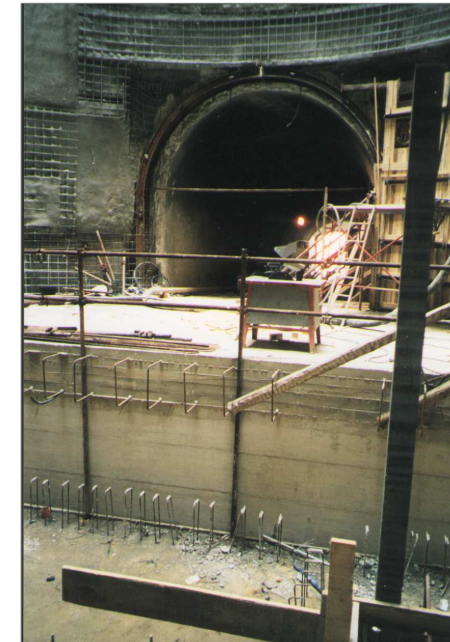
Vista della base del pozzo con lo sbocco della galleria.
