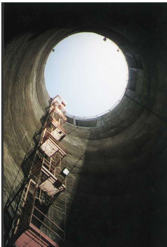
Un'immagine del pozzo ascensori a scavi ultimati. Il rivestimento sia provvisorio che definitivo delle pareti è stato realizzato mediante getto di spritz beton fibrorinforzato, a seguito di un accurato mix-design che garantisce il dovuto grado di finitura della superficie esterna.
