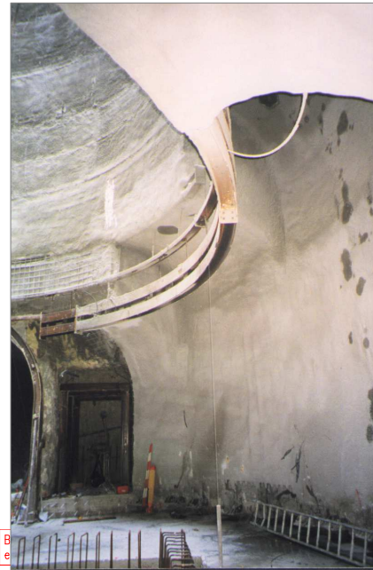
Vista della base del pozzo con getto del solettone pressoché ultimato. In primo piano il cunicolo che alloggerà la prima rampa delle scale di servizio, prima del getto del setto di separazione dal pozzo.
