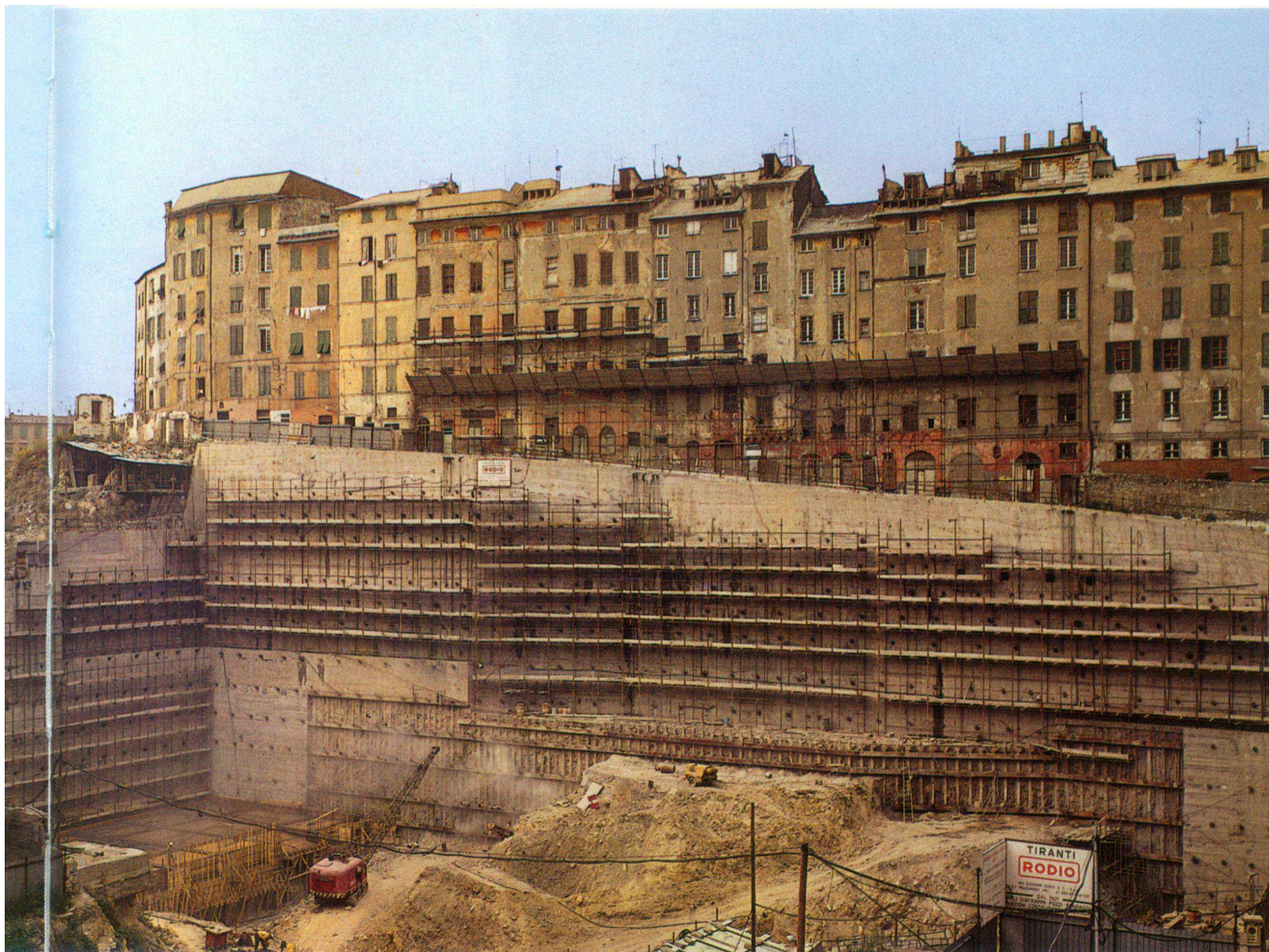
Genova Madre di Dio. Scavo di 34 m in argille, argilliti, blocchi calcarei e calcare fratturato. RODIO - 1975
