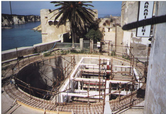
La sommità del pozzo ascensori, prima del montaggio degli stessi e prima della copertura definitiva che ripristina la fruibilità della piazza.
