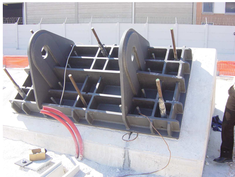
Uno dei blocchi di fondazione, con 6 tiranti Dywidag Ø 32 mm
