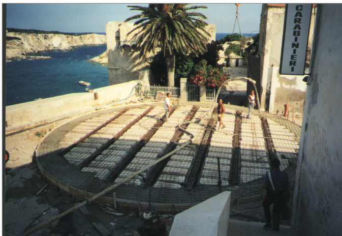
La struttura di copertura del pozzo realizzata in travi REP (travi miste acciaio-calcestruzzo) sulla quale verrà poi ripristinata la pavimentazione della piazza.
