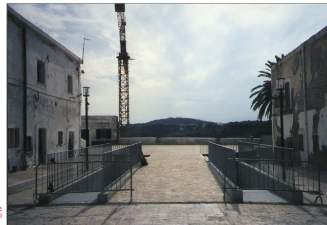
L'uscita delle due rampe pedonali, ben inserita nel contesto architettonico.
