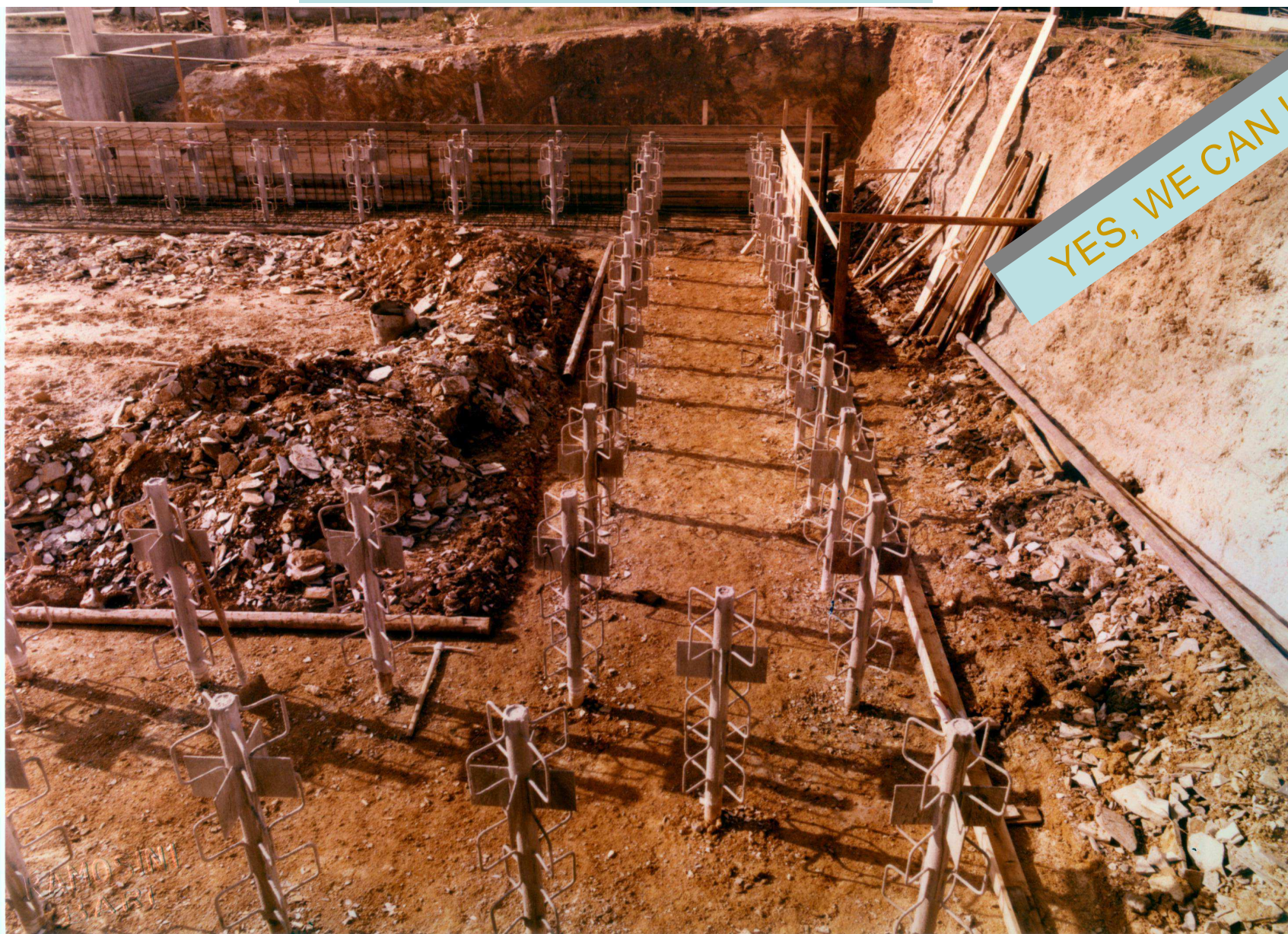
Breda Fucine Meridionali – Bari. Fondazioni del bunker per raggi \gamma - RODIO - 1978
