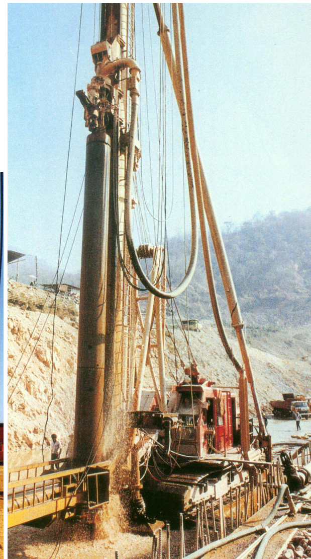
Diga in rockfill Khao Laem – Thailandia. Pali D = 760 mm (L = 15 - 55 m) eseguiti con martello a fondo foro per lo schermo impermeabile. RODIO – 1981-84
