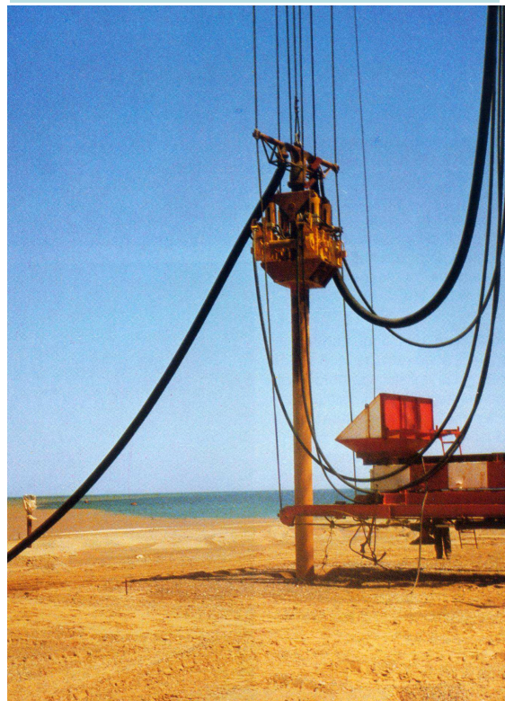
VIBROJETTING : INFISSIONE DEL RIVESTIMENTO CON VIBRATORE IDRAULICO + SCAVO ED EVACUAZIONE DETRITI CON GETTI D'ACQUA ED ARIA IN PRESSIONE.
