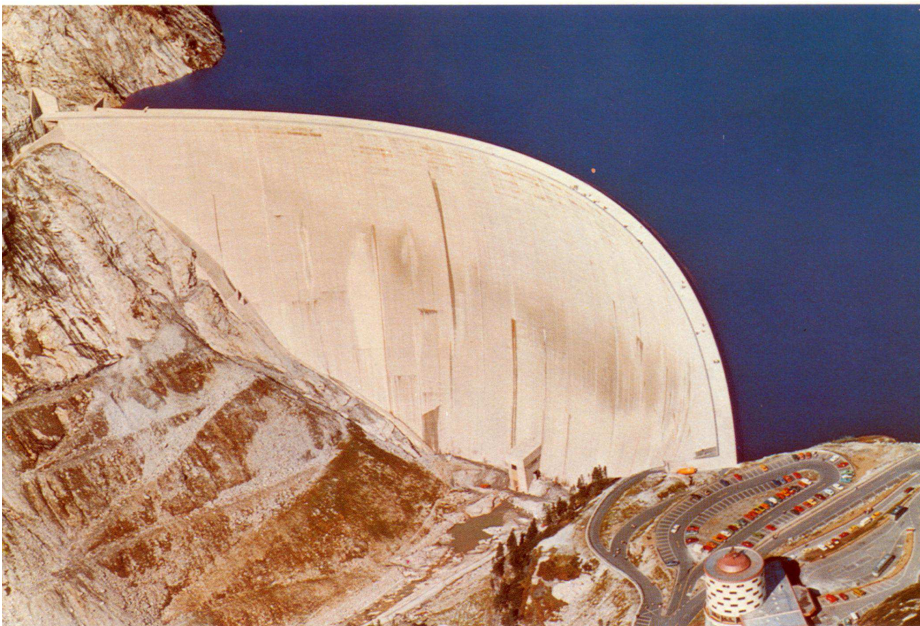
Diga di Kolbrein - Austria Iniezioni di sutura nel corpo diga e nella roccia d'imposta con procedimento RODUR
