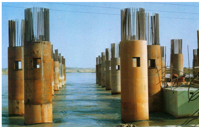
VIBROJETTING : INFISSIONE DEL RIVESTIMENTO CON VIBRATORE IDRAULICO + SCAVO ED EVACUAZIONE DETRITI CON GETTI D'ACQUA ED ARIA IN PRESSIONE.
