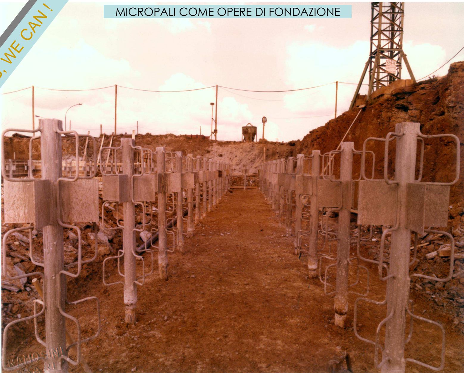
Breda Fucine Meridionali – Bari. Fondazioni del bunker per raggi \gamma - RODIO - 1978
