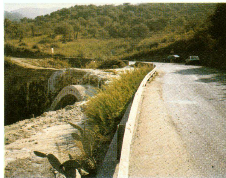
Foto 13 - Galleria S. Elia - Imbocco lato Messina visto dalla strada provinciale Cefalù-Gibilmanna.
