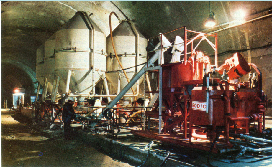
Una delle due centrali d'iniezione, completamente automatizzate
