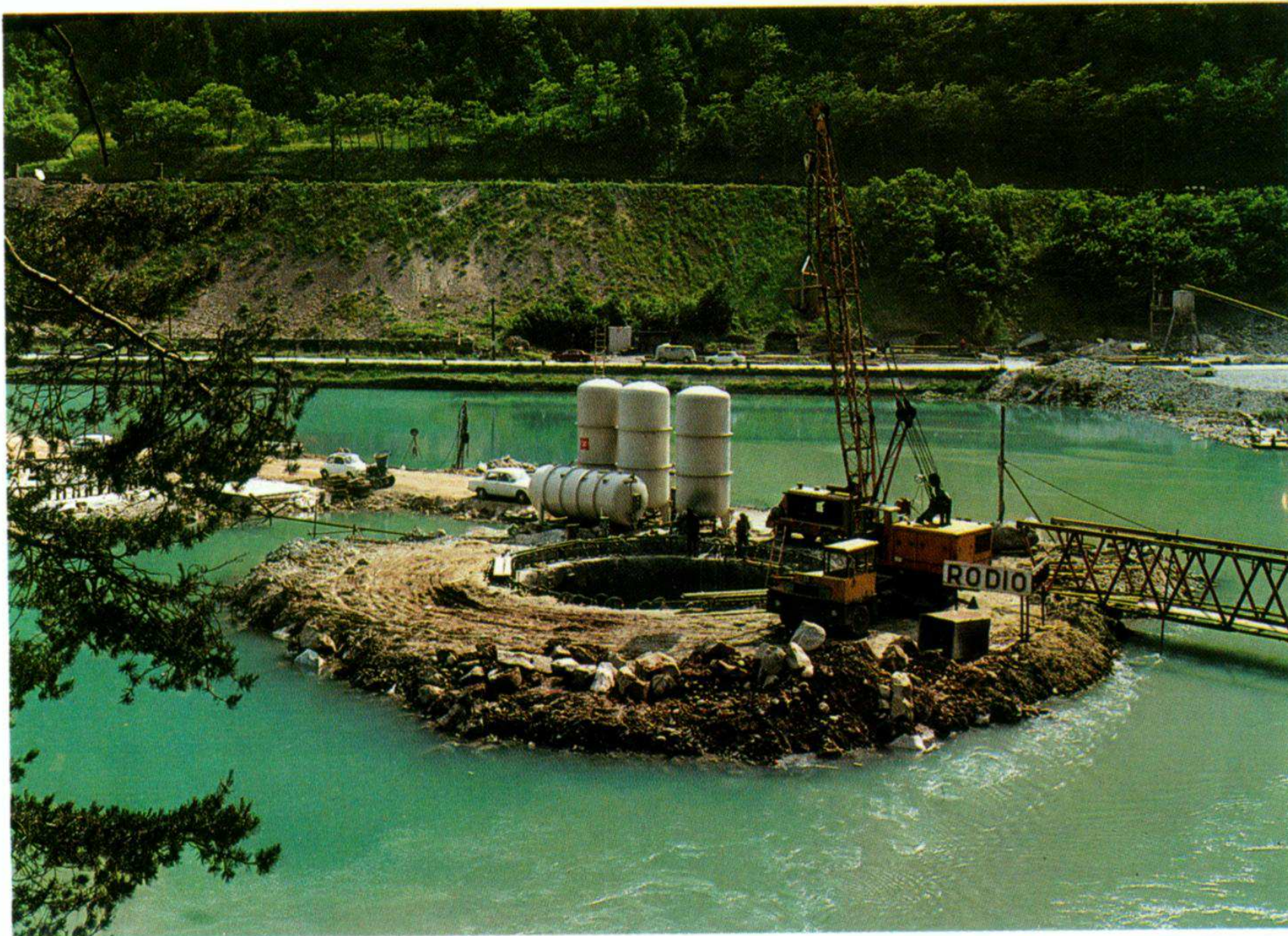
1970 – 71 Autostrada del Brennero Viadotto sul Lago di Fortezza Impresa RODIO
