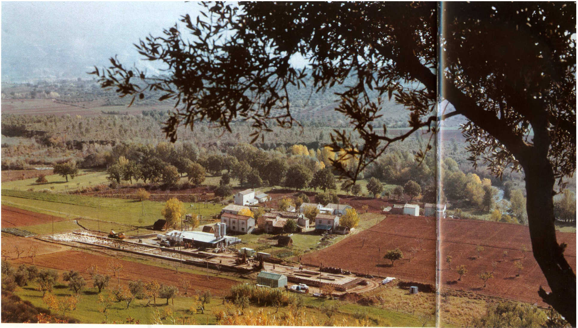
Vista d'insieme del cantiere
