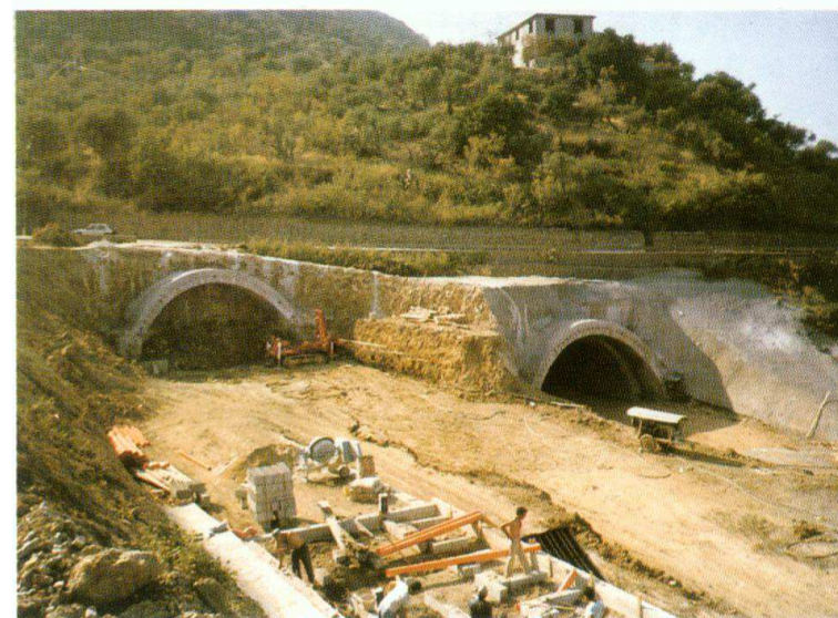
Foto 12 - Galleria S. Elia - Imbocco lato Messina.
