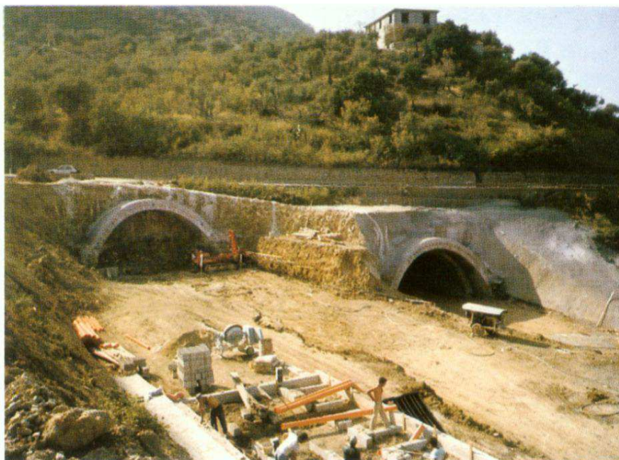
Foto 12 - Galleria S. Elia - Imbocco lato Messina.
