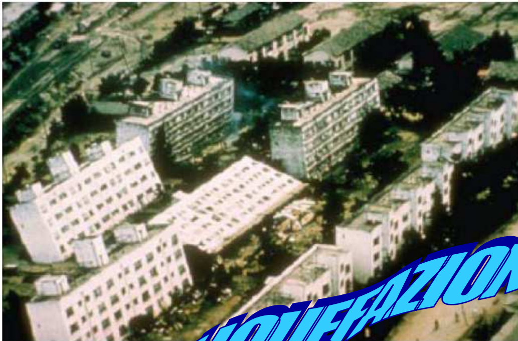
Terremoto di Niigata (Giappone 1964) : affondamento di edifici
