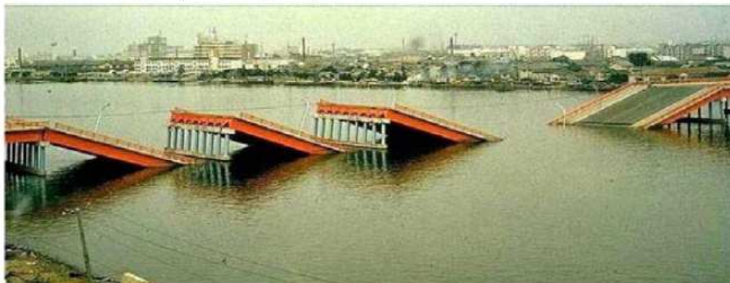
Terremoto di Niigata (Giappone 1964) : cedimento del ponte Showa
