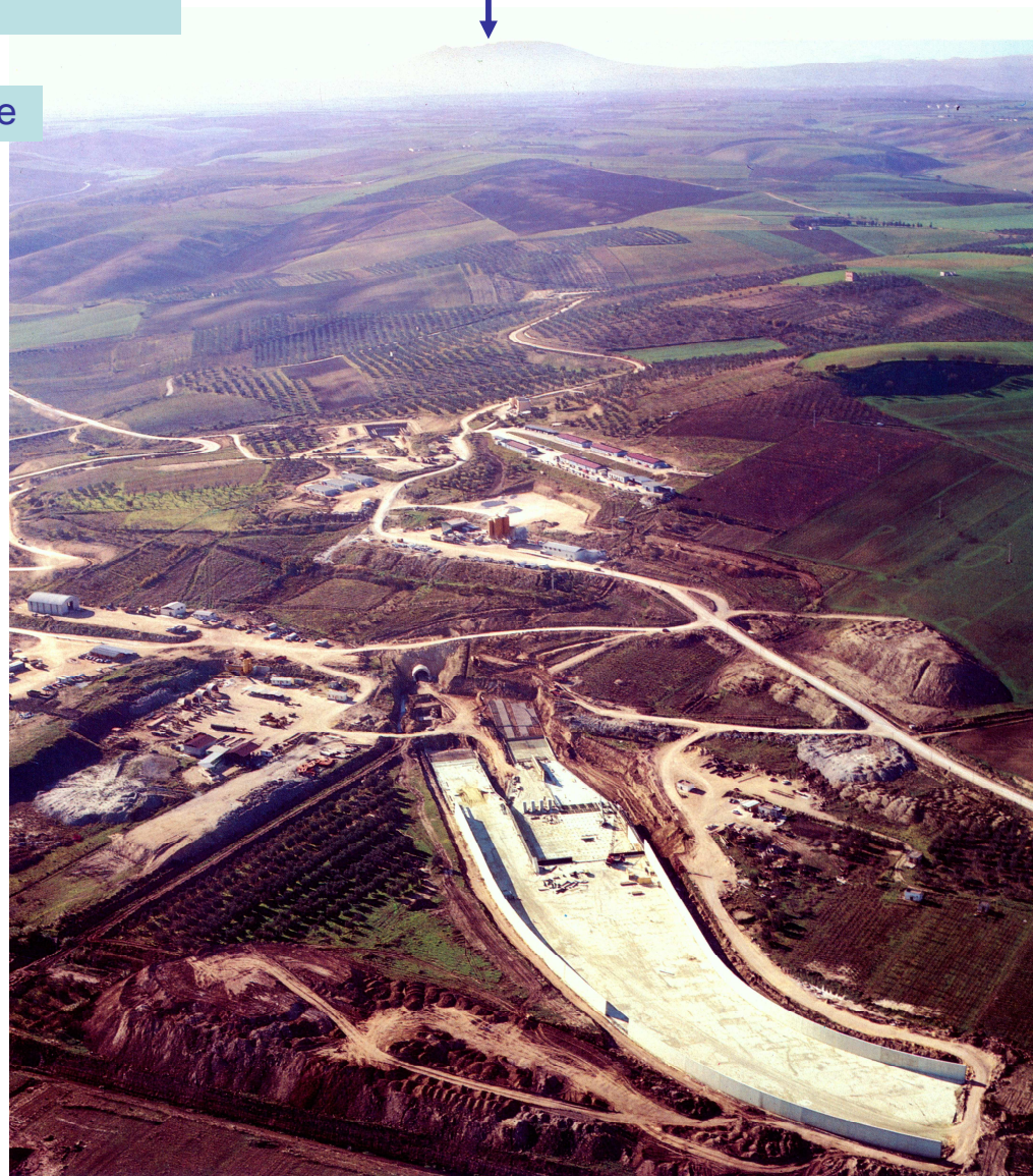
Il canale di restituzione, la vasca di dissipazione e lo sbocco dello scarico di fondo, visti da valle. Sullo sfondo il Vulture
