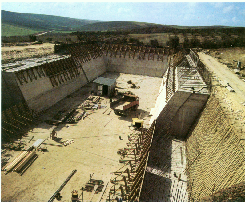
Sfioratore in fase di costruzione (visto da valle)
