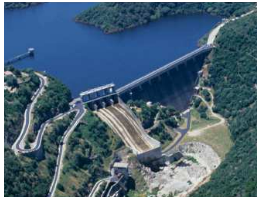
Diga a gravità alleggerita sul fiume Liscio (Sardegna) - ITALIA h = 69 m
