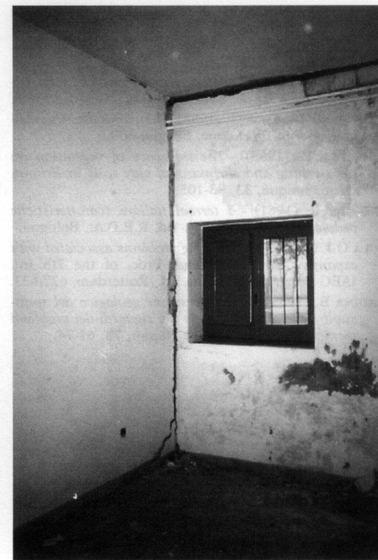
Figg. 11 e 12 - Santuario dell'Incoronata di Foggia: alcuni particolari del quadro fessurativo all'esterno ed all'interno della casa canonica.
