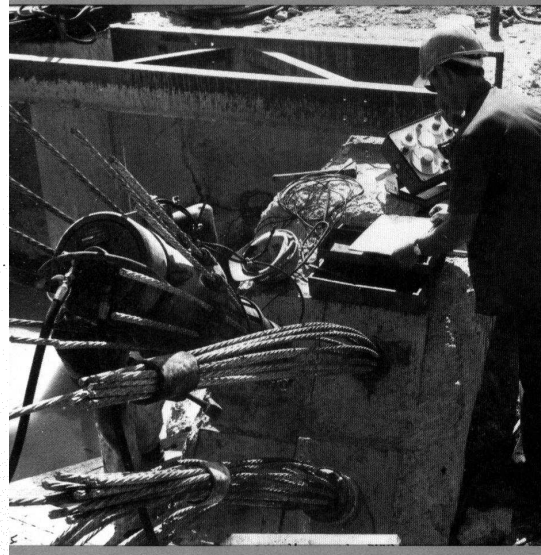
Mise en tension d'un tirant
