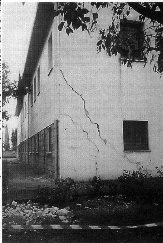
Figg. 11 e 12 - Santuario dell'Incoronata di Foggia: alcuni particolari del quadro fessurativo all'esterno ed all'interno della casa canonica.
