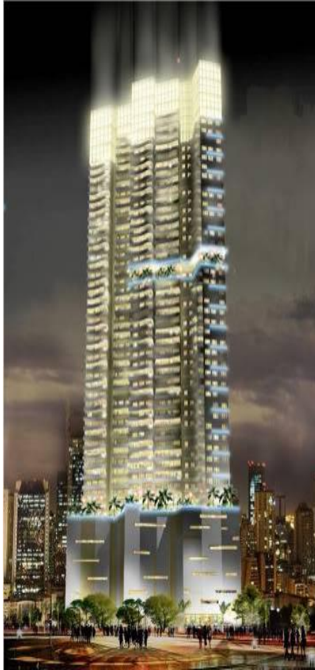
Anchor Skysuites - Manila Edificio di 56 piani
