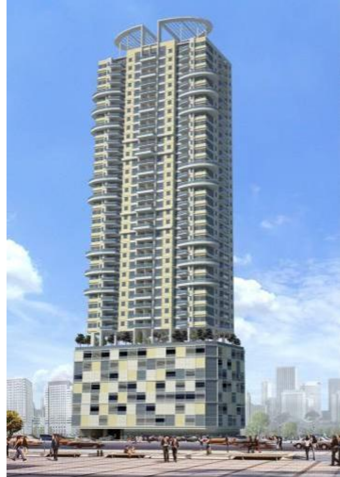
Wharton Parksuites – Manila Edificio di 40 piani
