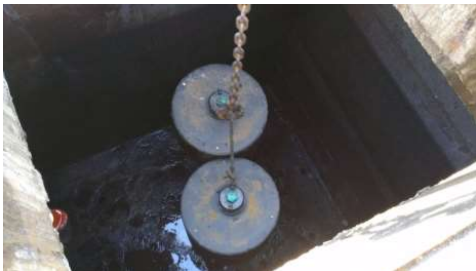
vasche di prima pioggia con trattamento di filtrazione in continuo e scarico in fosso di guardia
