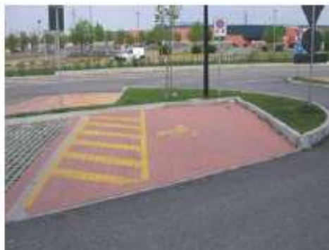
Parcheggio riservato - esempio di pavimentazione
