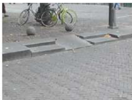
Abbinamento corretto tra rampa e scalini
