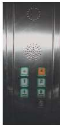
Pulsantiere sviluppate in orizzontale e con traduzione Braille
