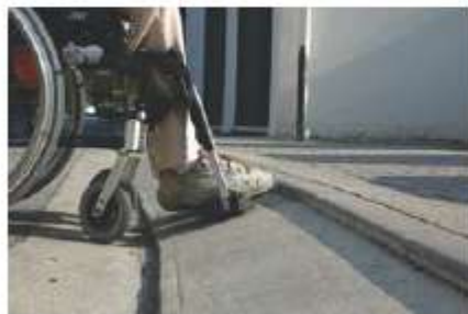
Esempio non corretto di rampa di raccordo
