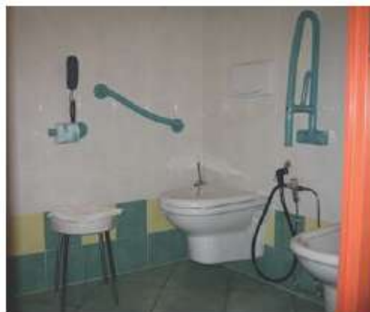
Corretta collocazione della tazza wc e degli ausili (maniglioni, doccetta, campanello di chiamata-citofono)
